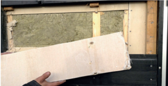
Afmontering af vindspærreplade
