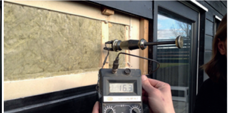
Måling af fugt bag vindspærreplade
